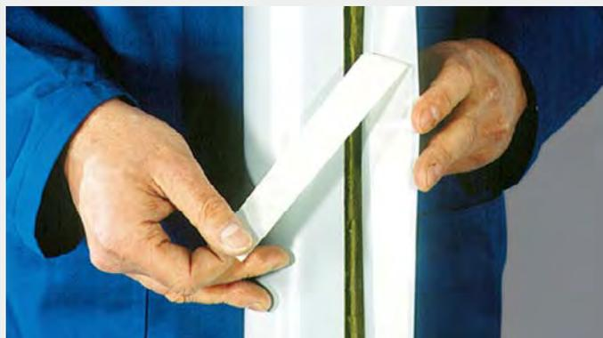
**фот. 414.2.** На прямой отрезок трубы накладывается цилиндр **TERMOROCK** а затем отрывается защитная лента и приклеивается самоклеящаяся закладка
