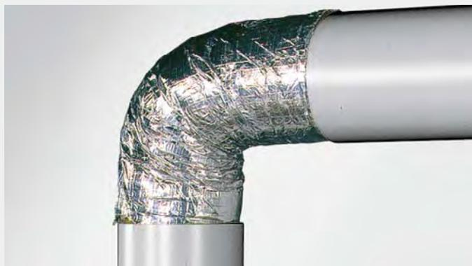
**фот. 414.4.** На прямой отрезок за коленом накладывается цилиндр **TERMOROCK**
